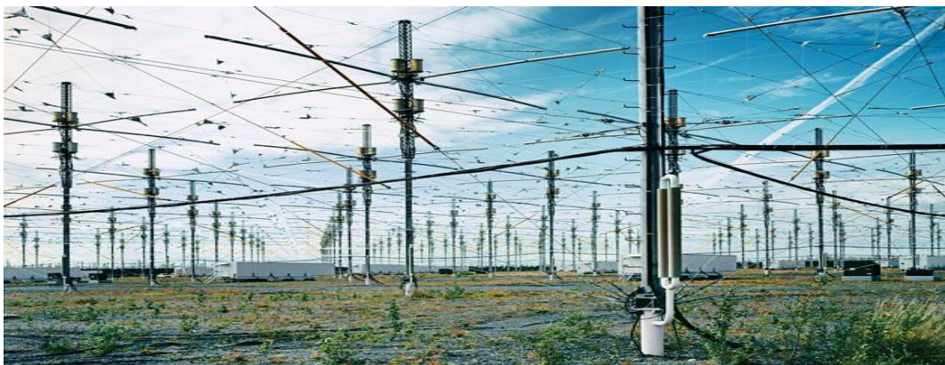
Die berühmten HAARP-Antennengruppen, heute auf der ganzen Erde verbreitet. Das ist keine Abbildung von Poker Flats – dort wird man vor, während und nach dem Fotografieren erschossen.
