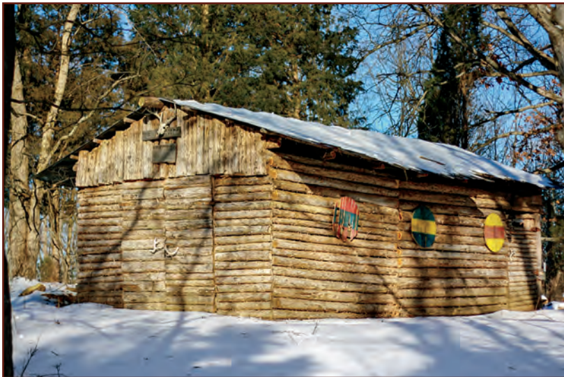
Eine Met-Halle der Wikinger in den Appalachen, die von dem Bruder des Verfassers, Zachary, auf dem brachliegenden Land ihres Elternhauses, einer Ziegenfarm in Kentucky, errichtet wurde.
